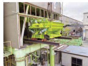
ミキサー(SF1500)操作盤入替工事(2)
