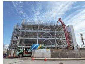
那覇空港貨物ターミナル 立体駐車場 新築工事(2)
