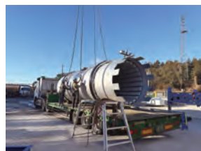
バグドライヤ入替工事
