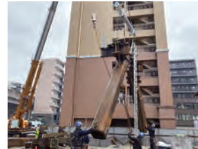
(仮称)流山おおたかの森 新築工事(1)
