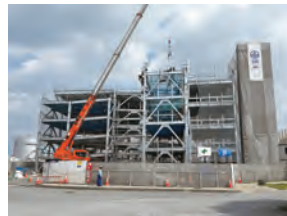
那覇空港貨物ターミナル 立体駐車場 新築工事(1)
