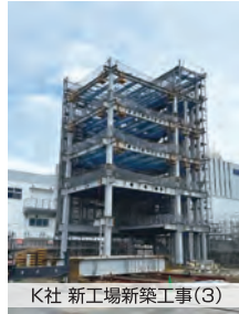
K社 新工場新築工事(3)
