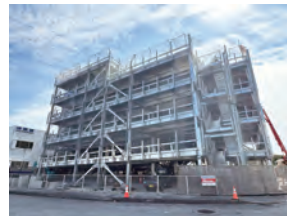
那覇空港貨物ターミナル 立体駐車場 新築工事(3)
