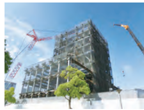
大手メーカー 新本社ビル建設工事(4)
