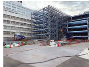
兵庫医大西宮2期計画 立駐棟躯体設備工事
