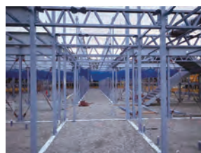
入間 仮設建物設置工事(1)
