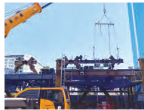
(仮称)流山おおたかの森 新築工事(3)
