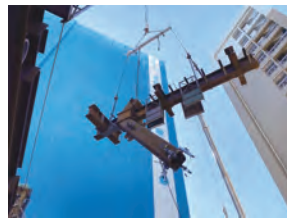
(仮称)流山おおたかの森 新築工事(2)
