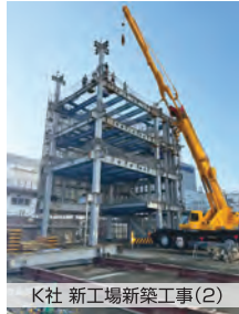
K社 新工場新築工事(2)
