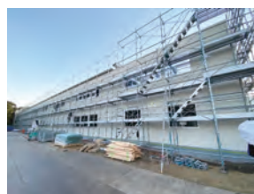
入間 仮設建物設置工事(3)
