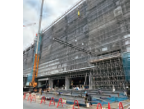
GLP 尼崎 南棟 新築工事
