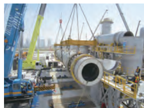
中温加熱処理プラント組立工事 その他(1)
