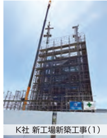
K社 新工場新築工事(1)
