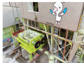
ミキサー(SF1500)操作盤入替工事(1)
