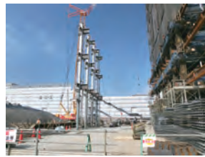
大手メーカー 新本社ビル建設工事(1)
