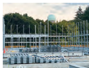
入間 仮設建物設置工事(2)
