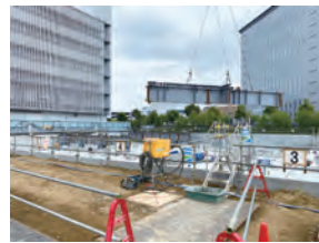
(仮称)千葉第3ビル 新築工事(1)
