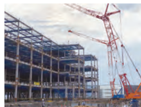
東名綾瀬 新築工事
