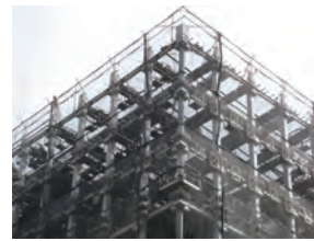
大手メーカー 新本社ビル建設工事(5)
