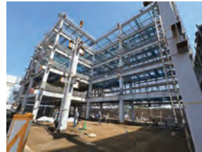
K社 新工場新築工事(4)
