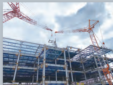
大型物流倉庫
