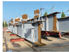
(仮称)千葉第3ビル 新築工事(2)
