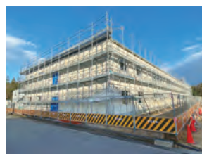
入間 仮設建物設置工事(4)
