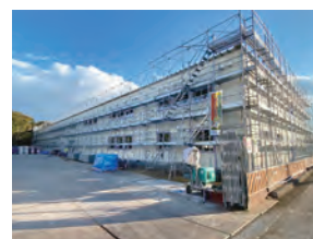
入間 仮設建物設置工事(5)
