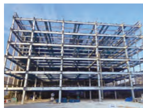
須磨パティオ 新立体駐車場 建設工事
