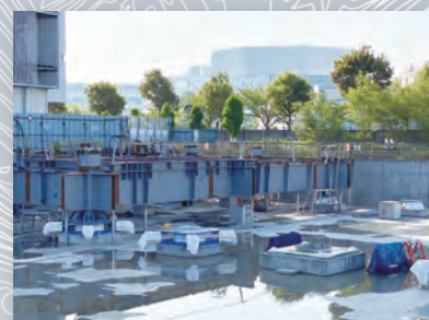
データセンター
