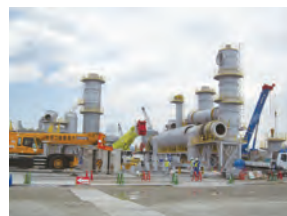
中温加熱処理プラント組立工事 その他(2)
