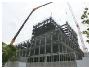
大手メーカー 新本社ビル建設工事(3)
