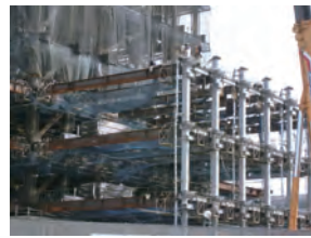
大手メーカー 新本社ビル建設工事(2)
